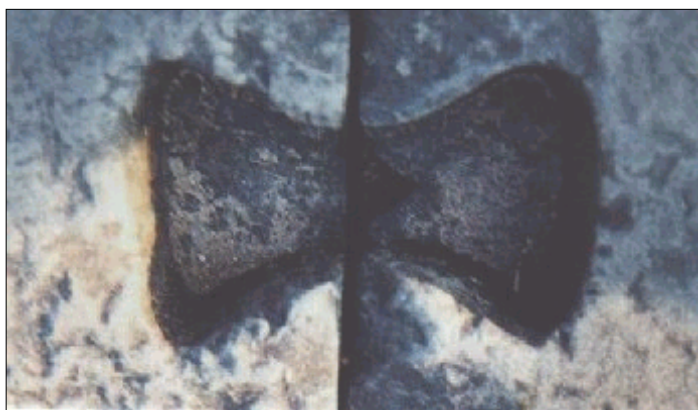
FIGURA 31. BLOCCHI DI PIETRA CON IMPRONTA DEI “MORSETTI” DI METALLO
