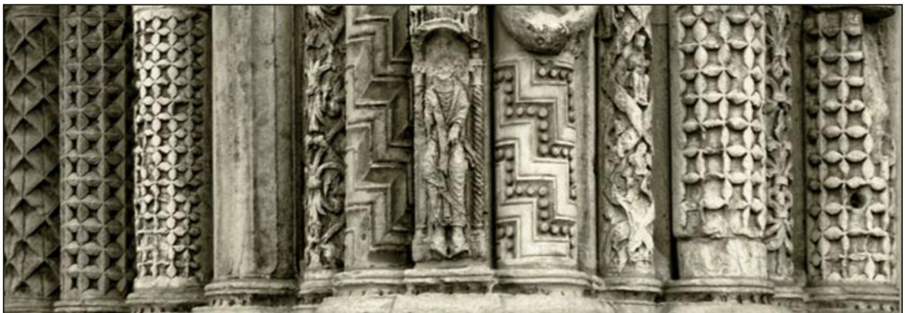
FIGURA 11. PORTALE CENTRALE REALE - BASI COLONNE
