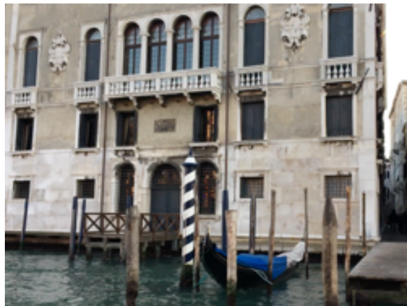
Venezia; Palazzo Volpi, on the left side of Canal Grande, opposite Palazzo Donà della Trezza
